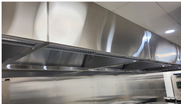
04. 급배기후드 (SUPPLY & EXHAUST HOOD)
